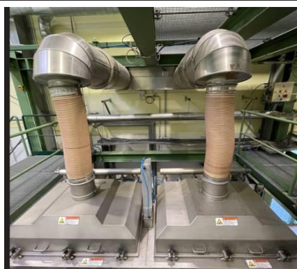
filtragem externa com 2 seções de coifas com 6 filtros tipo cartucho cada
